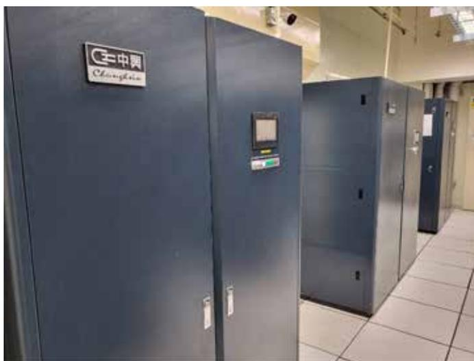
高顯熱 EC FAN 恆溫恆濕箱型機
